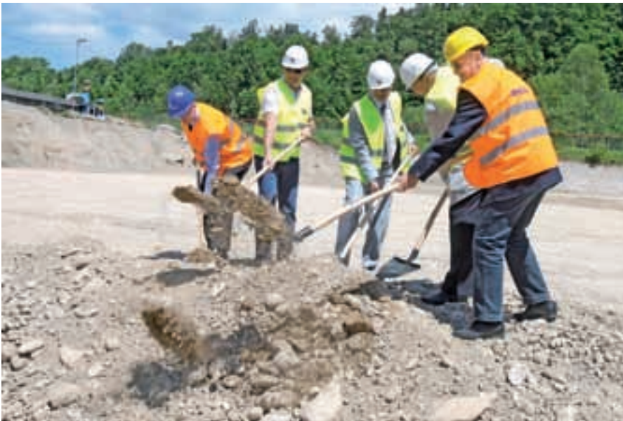
V Zarici pod Kranjem so začeli graditi novo čistilno napravo.
