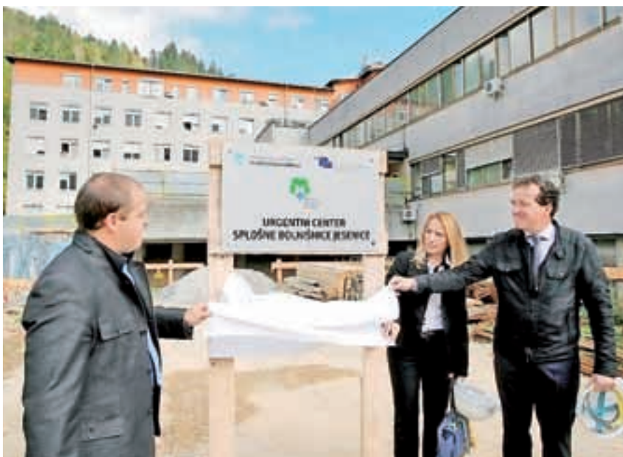
Na Jesenicah so začeli graditi nov urgentni center.
