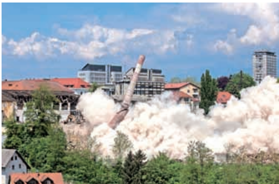
Nad 150 kilogramov razstreliva je bilo potrebnega za rušenje dimnika na Stari Savi v Kranju.
